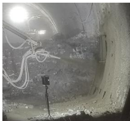
(a) 隧道实际喷浆场景
