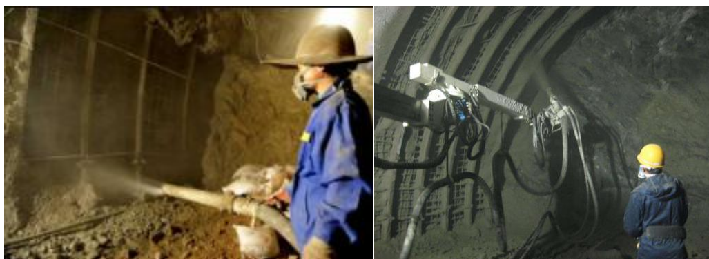
(a) 手持喷枪喷浆操作
