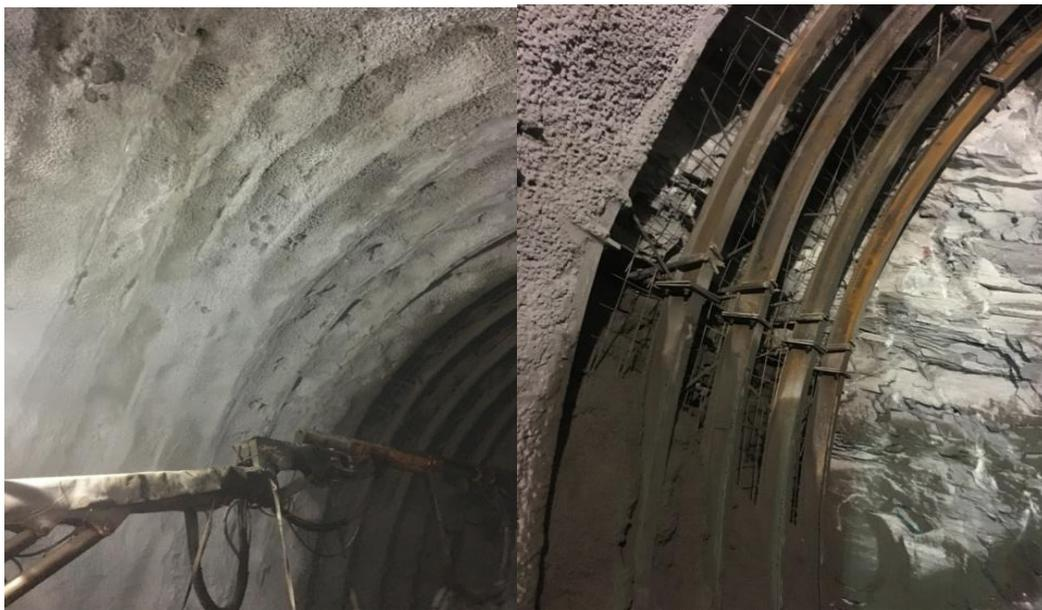
图 3-13 湿喷现场隧道支护结构实物图
