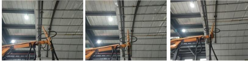
(b) 在钢拱位置的喷枪斜喷示意图
