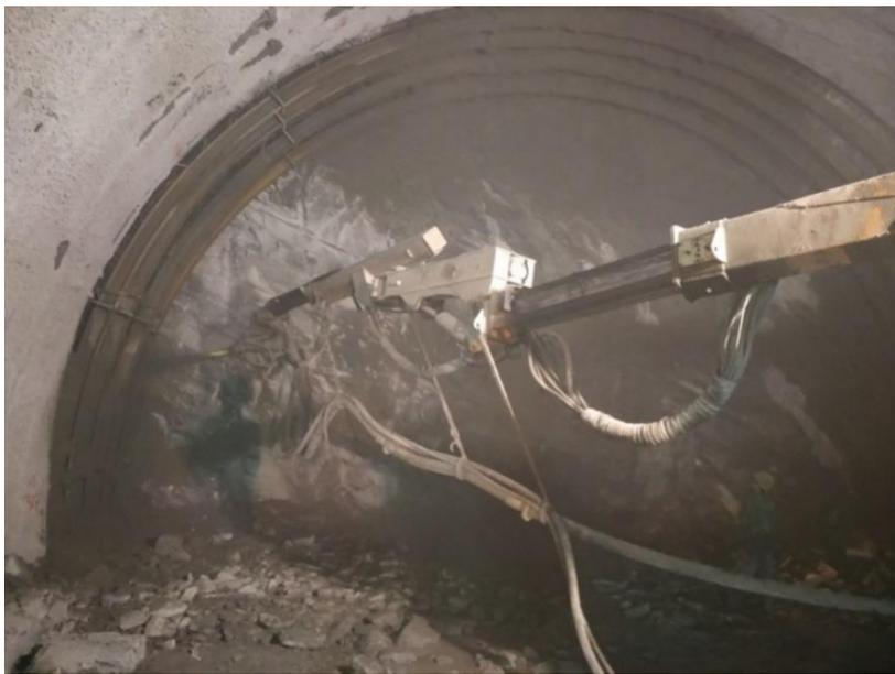
图 3-1 隧道湿喷现场
