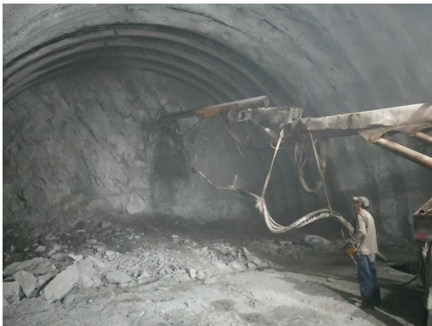
图 1-1 人工隧道喷射示意图
